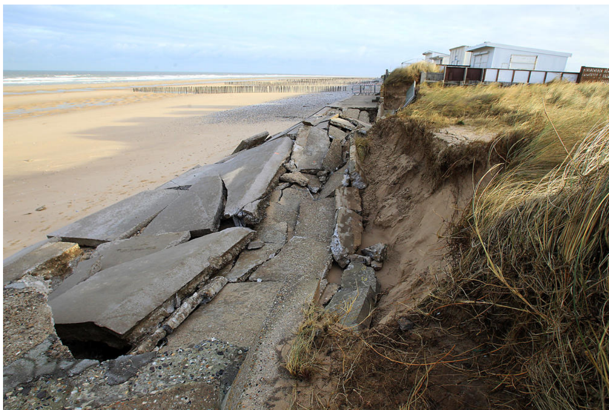
Figure 5. La digue de Sangatte après le passage de la tempête Xaver
